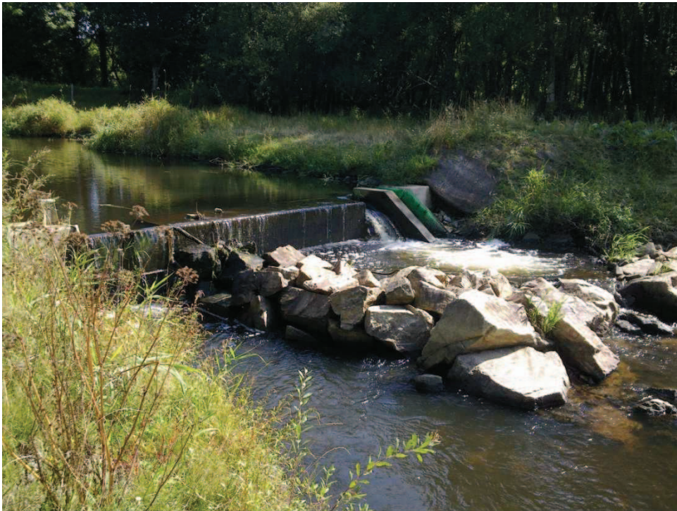
Figure 20 : Seuil dans l'Ellé à Pont Saint Yves et ouvrage de franchissement piscicole (vue aval en été 2016)
